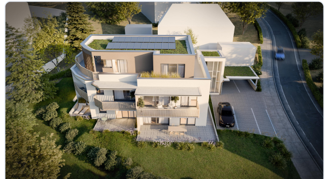
Vogelperspektive mit Terrassen, Balkonen & PV-Anlage
